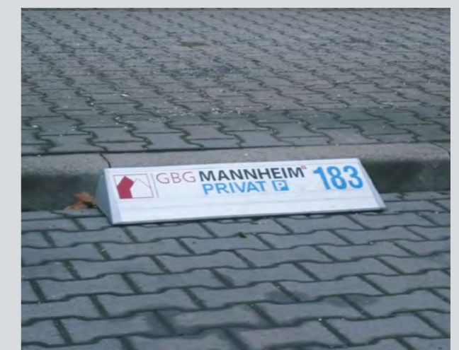
Kurze Anfahrtschwelle als Parkplatzkennzeichnung
